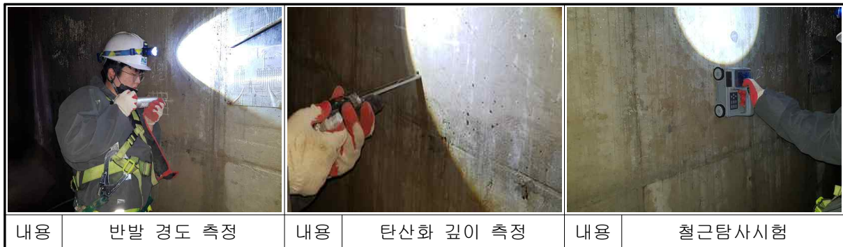
【사진 11.5】 양주지축 재료시험 전경
